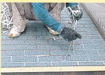
→ 型枠除去工
