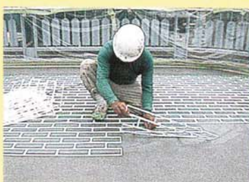
→ 墨出し工 → 型枠貼付工
